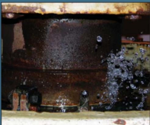
*Le perdite portano alla corrosione delle apparecchiature e a premature rotture dei cuscinetti*
